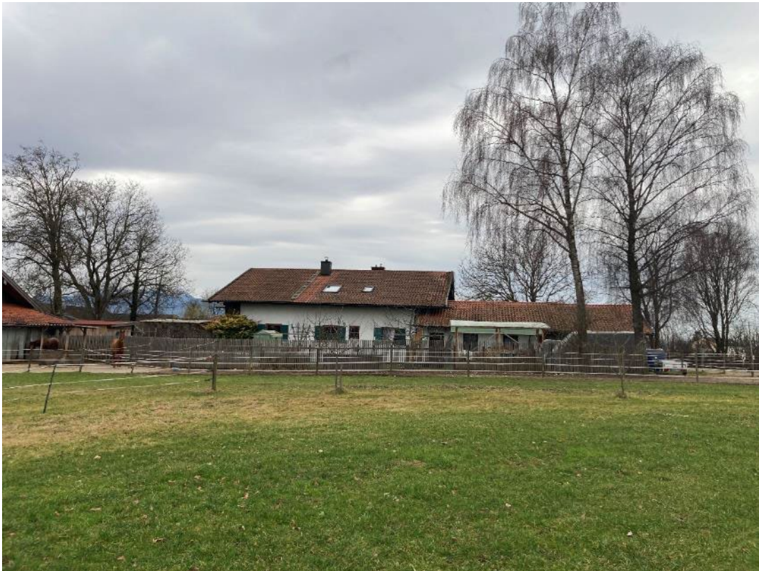
Abbildung 10: Wohngebäude mit Pferdehaltung im südwestlichen Plangebietsteil. Blick von Osten.
