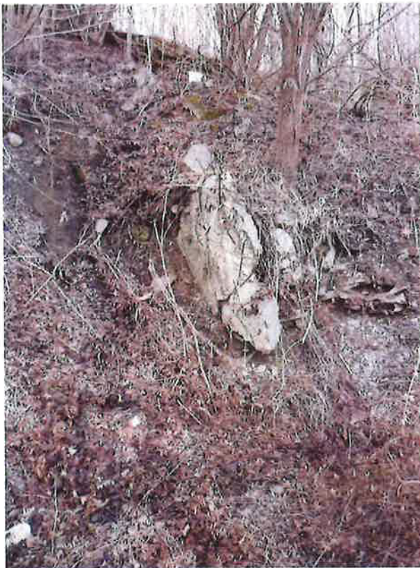
Foto F2: Richtung Sondierstellen H3 und K3 / Hang mit grobem Bauschutt
